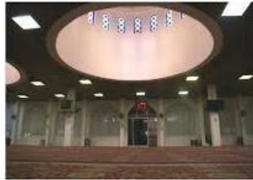
Rajah 3.12: Tingkap kaca berwarna kekal yang dipasang di dalam kubah baik untuk pencahayaan tetapi membawa bersama kepanasan ke dalam ruang dalaman masjid
