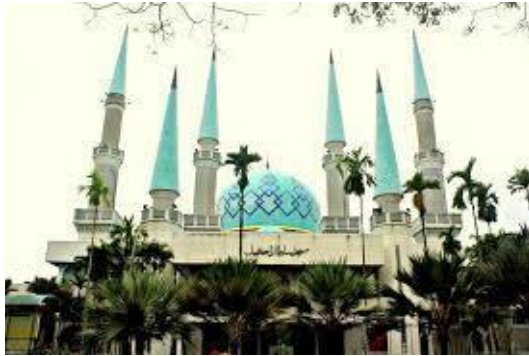
Rajah 3.11: Bumbung dan kubah Masjid yang dibina tidak mempunyai pembukaan untuk melepaskan udara panas yang terkumpul keluar dari ruang dalaman masjid
