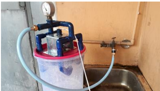
Rajah 5.3: Pemasangan hos paip
