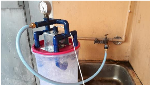
Rajah 12. Pemasangan hos paip
